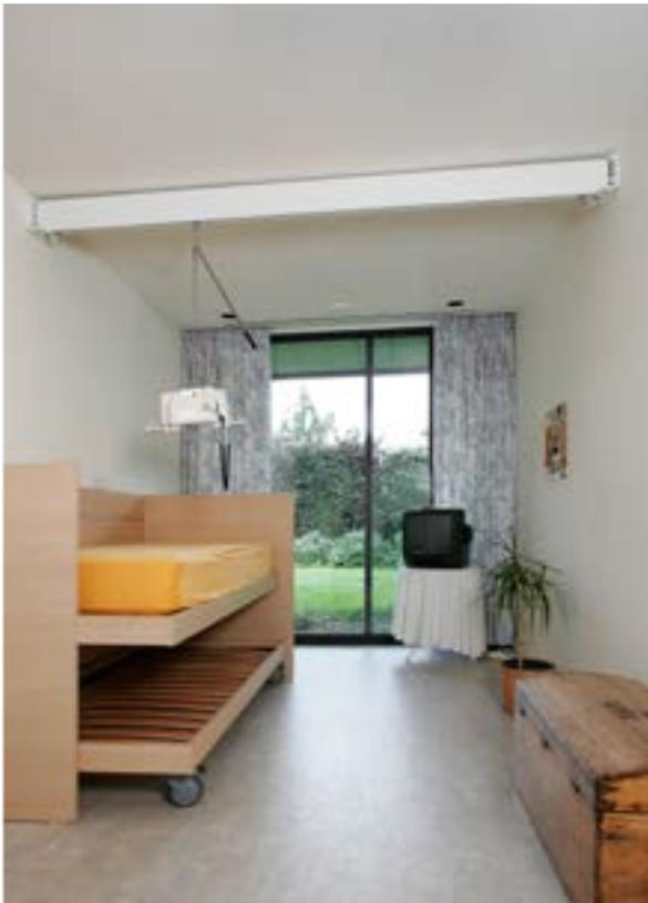
Falls eine Deckenbefestigung nicht möglich ist, kann mit einer verstärkten Wand-zu-Wand Schiene bis 7m freitragend das Problem gelöst werden. Sie sind auch dann die Lösung, wenn die Decke nicht stark genug ist, um als tragendes Element für die Schienen zu dienen.
